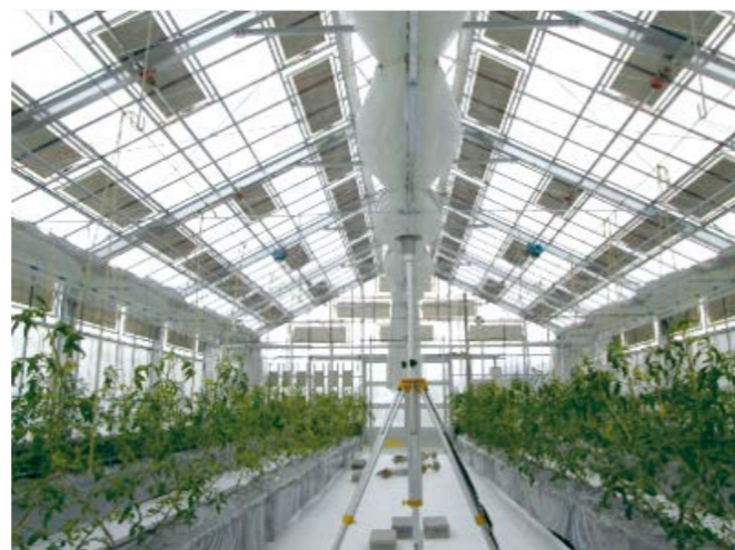
太陽電池パネル温室の内部
